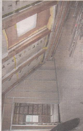
**Dämmarbeiten unter der Dachschräge. An vielen Stellen werden neue Trennwände eingebaut**
